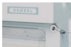
Selagem do acesso ao interior do quadro
