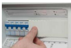
Máscaras para cobertura de módulos não utilizados
