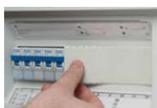
Fornecidos com máscaras para ocultar módulos não utilizados
