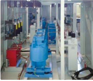
Instalação de tratamento de água
